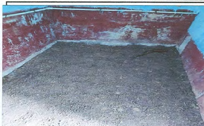
Foto 2: Mejoramiento de servicios sanitarios y sus accesorios.
