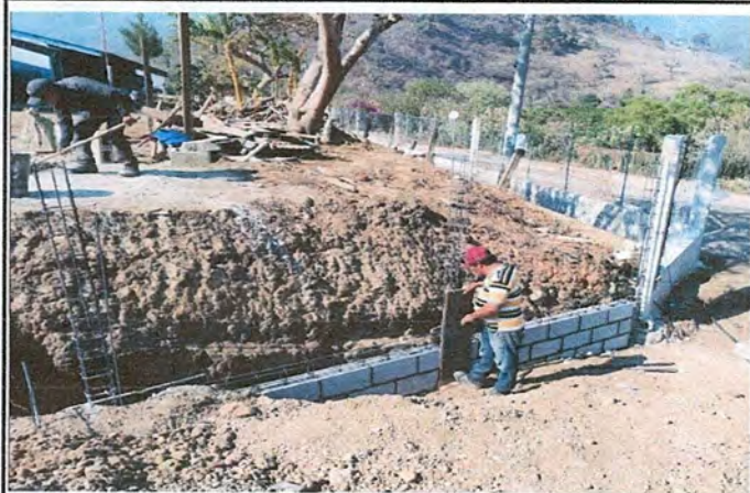
Foto 3: Mejoramiento de reparación de muro perimetral.
