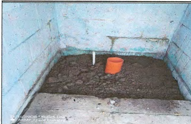
Foto 1: Mejoramiento de servicios sanitarios y sus accesorios.
